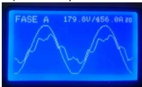
Depois da Instalação do Filtro:
